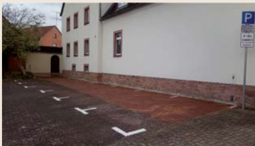
Der Parkplatz am Haus der Begegnung ist fertig geworden.
