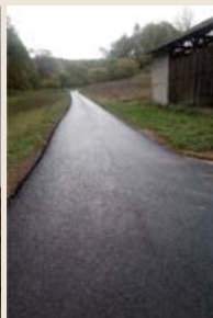
Neue Straßendecke auf dem Grundweg
